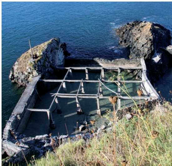
Cetária Praia Sonreiras, Cedeira (A Coruña)
